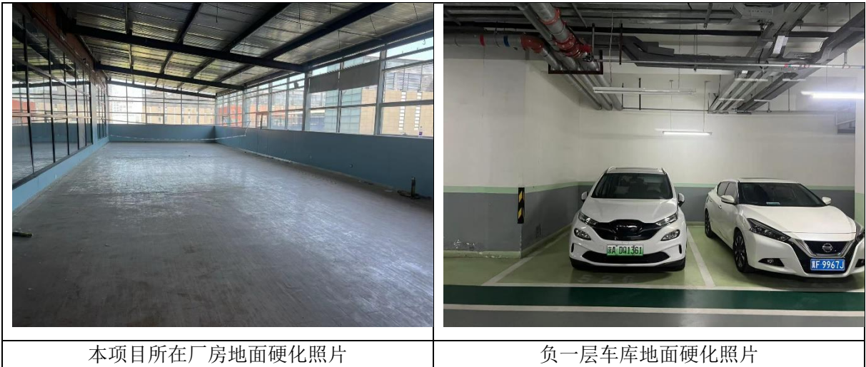
图 5.2-6 中试车间地面及负一层地面硬化照片
