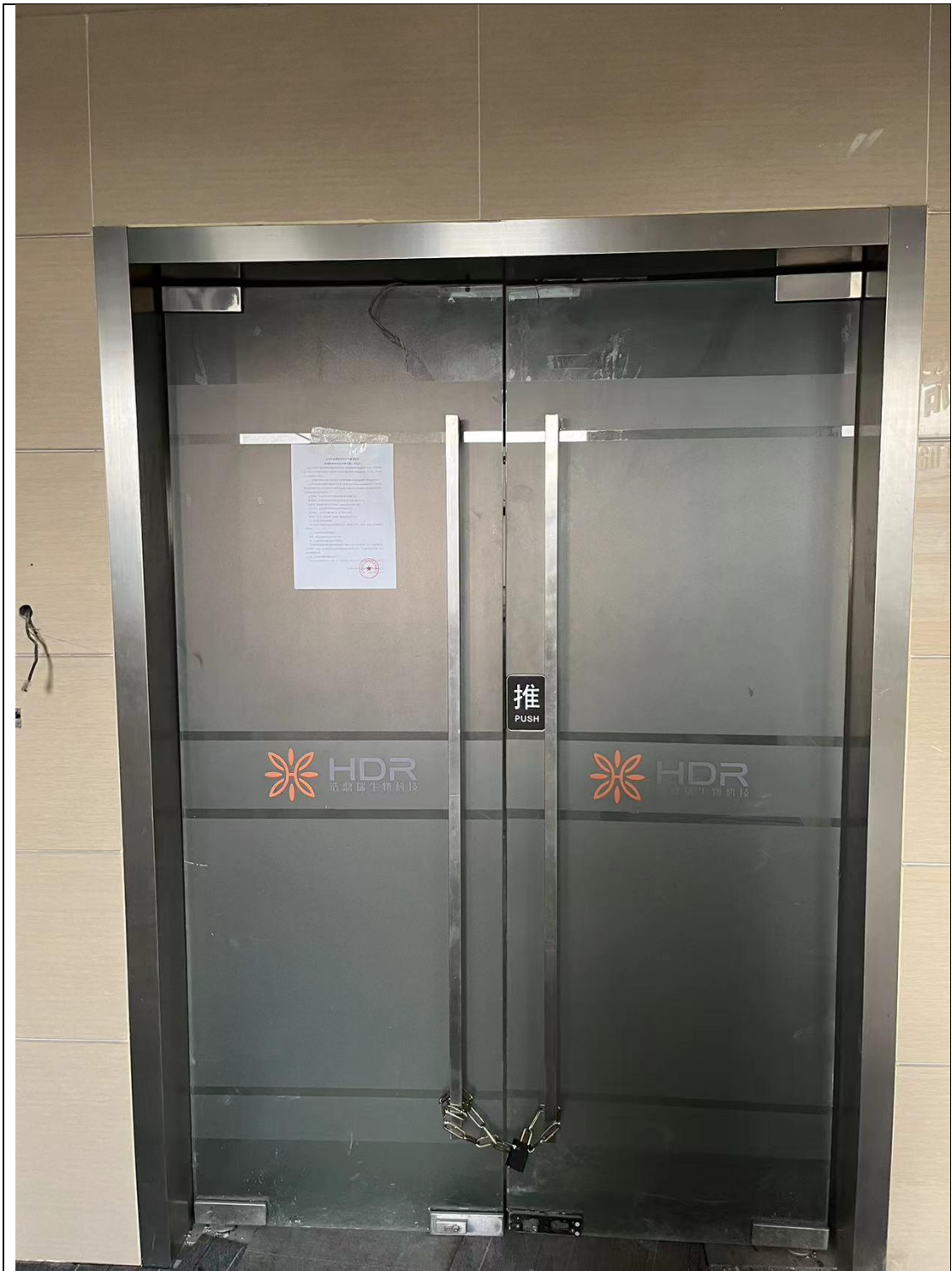
项目厂址门口张贴公告
