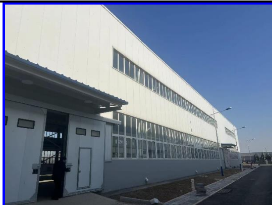
机加工车间（1#车间）外部
