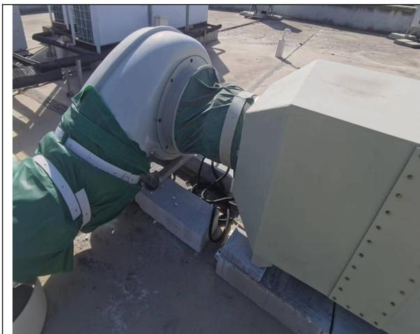
风机设置基础减振
