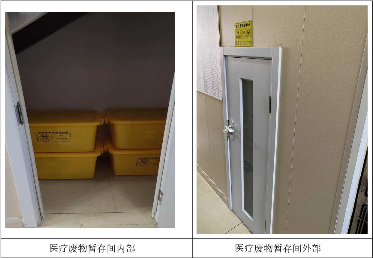
图 4-3 项目固体废物暂存处照片
